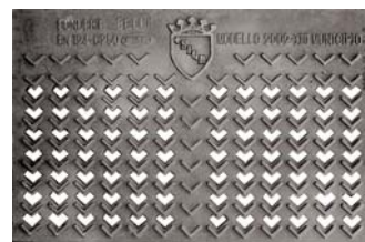
Superficie orizzontale forata per migliore il deflusso delle acque meteoriche in caso di ostruzione della bocca di lupo
