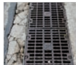
Installazione canaletta senza bordo
