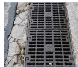
Installazione canaletta senza bordo
