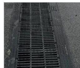
Installazione canaletta con bordo
